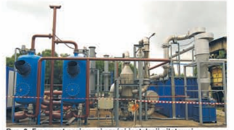
Rys. 3. Fragment naziemnej części instalacji pilotowej georeaktora w KWK Wieczorek
