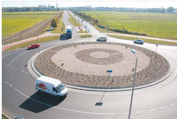
Modernizacja drogi krajowej nr 5, odcinek ul. Fabryczna – południowa granica miasta – II etap – Leszno – inwestor Miasto Leszno
