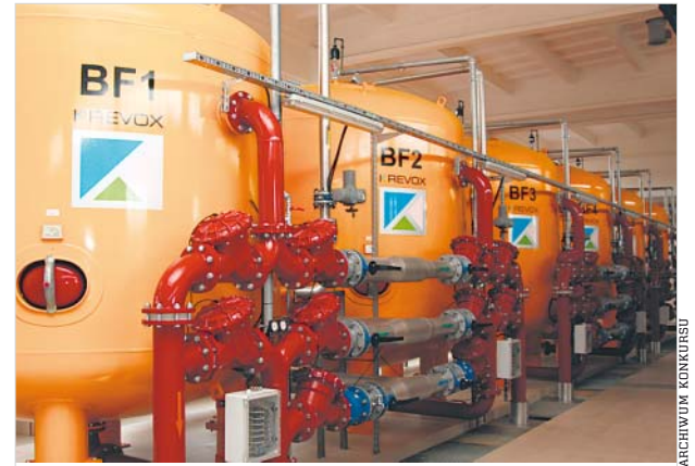
Modernizacja Stacji Uzdatniania Wody, ul. Mazowiecka 3, Płońsk – inwestor Przedsiębiorstwo Gospodarki Komunalnej w Płońsku Sp z o.o.
