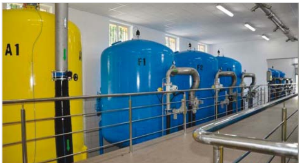
Stacja uzdatniania wody w Bolesławcu
