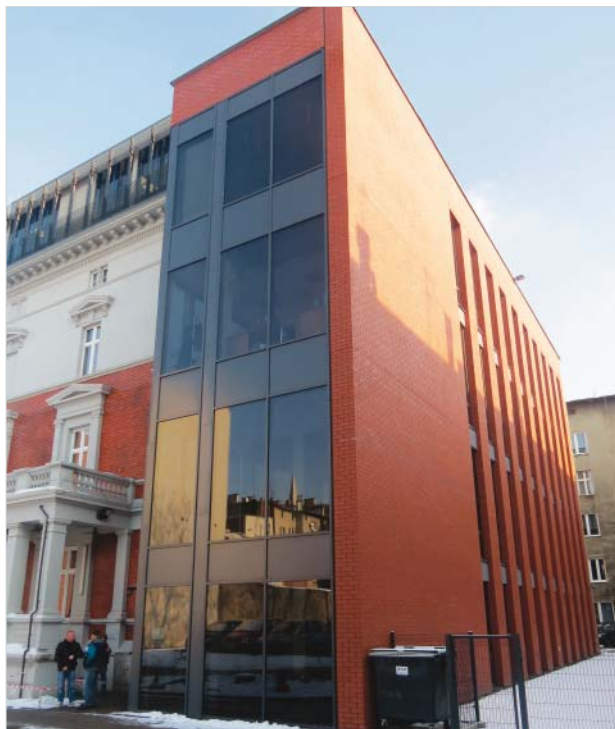
♦ Powiatowy Urząd Pracy w Zabrze
