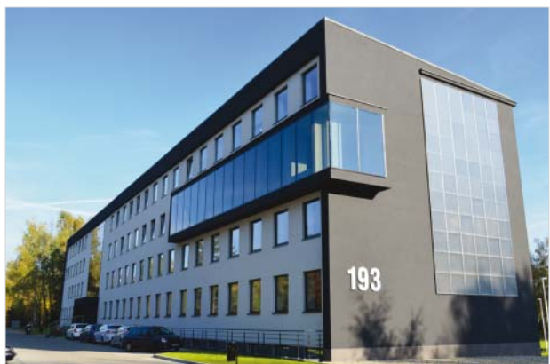
♦ Budynek w Katowicach
