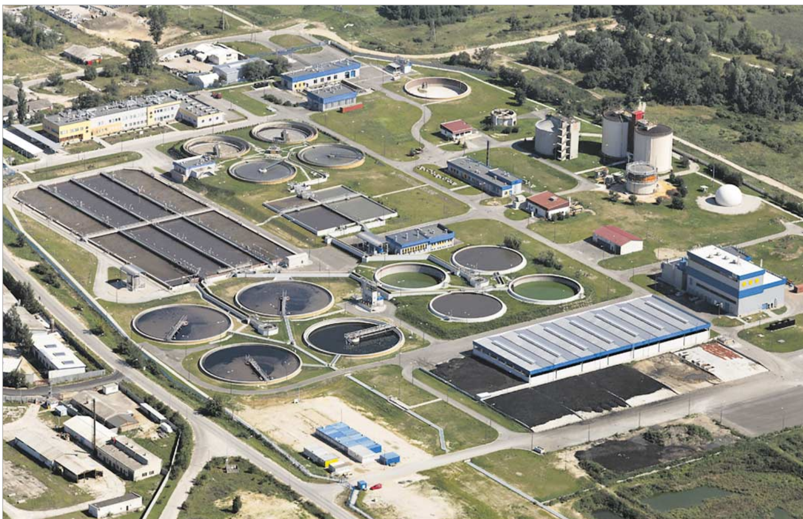
↑ Oczyszczalnia ścieków w Sitkowie pod Kielcami
