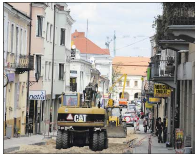
Trzeba było położyć dziesiątki kilometrów rur, aby kielczanie dalej mogli korzystać ze zdrowej i czystej wody. Układanie infrastruktury na ul. Małej. W tle miejski ratusz i rynek
